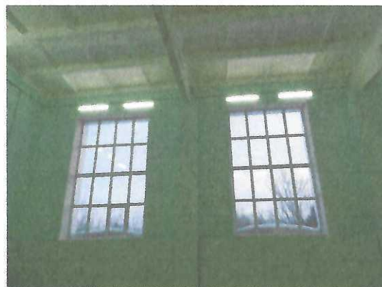
Внутренний вид помещений здания школы на момент обследования Установлено отсутствие трещин осадочного характера, следу замачивания конструкций, их не нормированные прогибы
