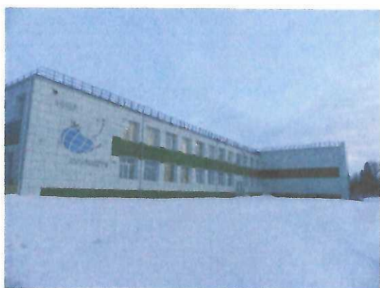
Фасады здания школы на момент обследования Внешняя отделка выполнена металлокассетами с декоративной отделкой
