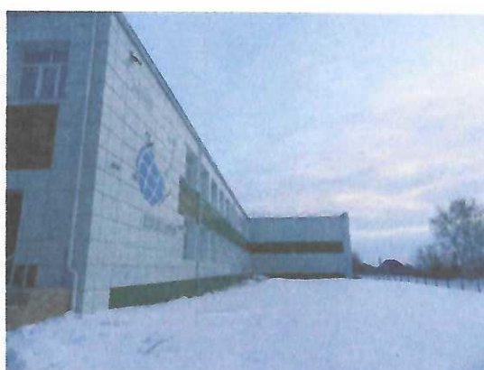
Фасады здания школы на момент обследования Внешняя отделка выполнена металлокассетами с декоративной отделкой
